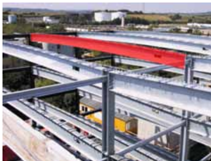
271 Träger vorspannen im Stahlbau Beam cambering
