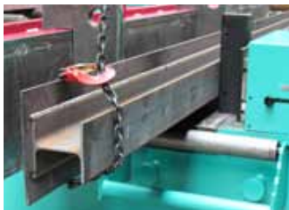
119 Geschweisste Träger richten Welded beam straightening
